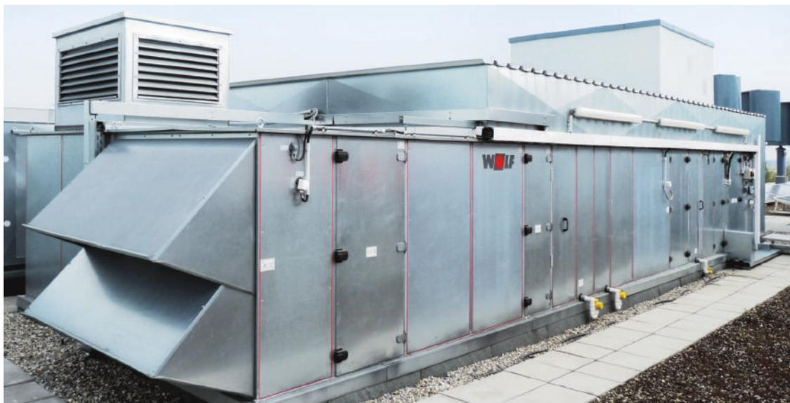
Установка кондиционирования воздуха, установленная на крыше и обеспечивающая подачу приточного воздуха объемом 22.000 м<sup>3</sup>/час, была недавно дооснащена установкой увлажнения воздуха.
