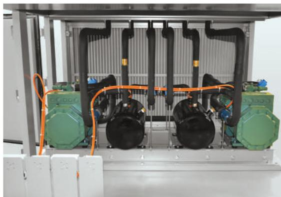
Установка для кондиционирования воздуха на крыше имеет производительность 22.000 м<sup>3</sup>/час, недавно она была оснащена установкой для увлажнения воздуха.
