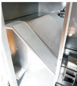
Рекуперация тепла посредством высокоэффективного противоточного пластинчатого теплообменника (ПТО).
